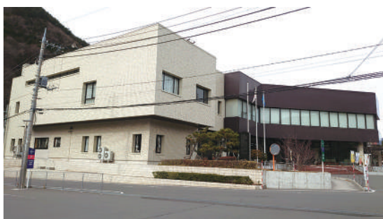
老朽化が進む役場庁舎
