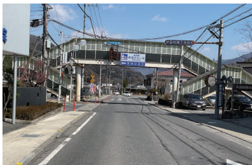
道の駅付近 国道120号
