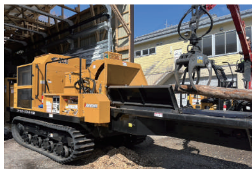
チップパー稼働前の試運転
