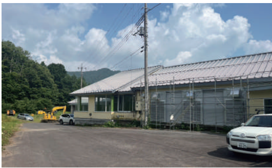
バイオマス発電所 内装工事中
