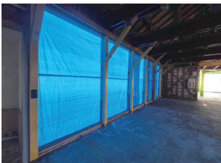
改装中の旧レストハウスポニー
