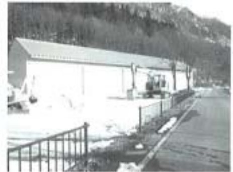
建設中の除雪車格納庫
