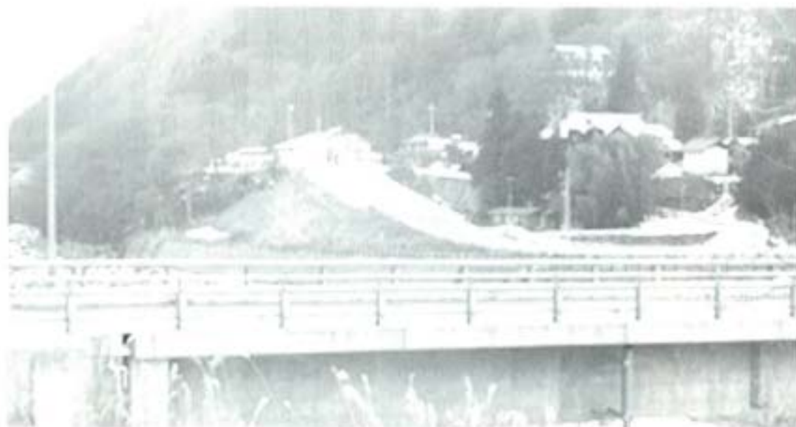
全面2車線となった摺淵花咲線
