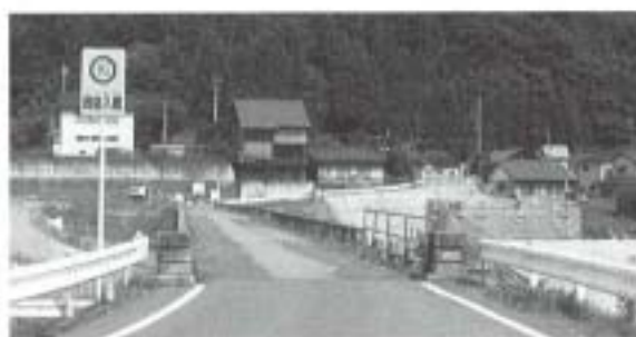
建設中の御座入橋
