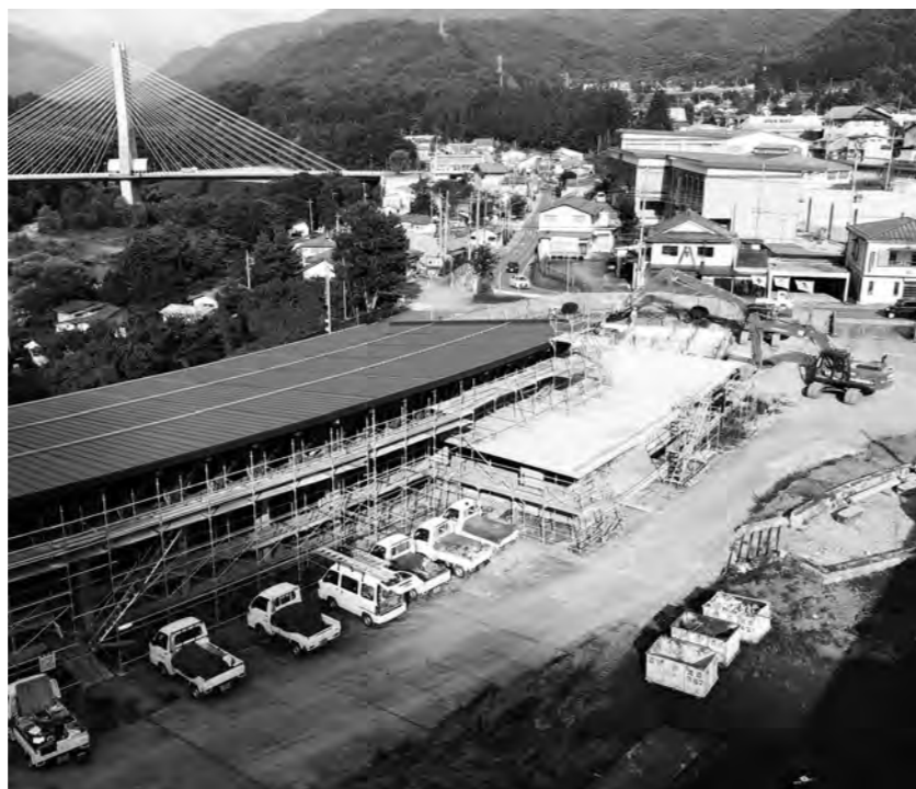
尾瀬大橋方面を望む、8月29日現在の工事の様子
