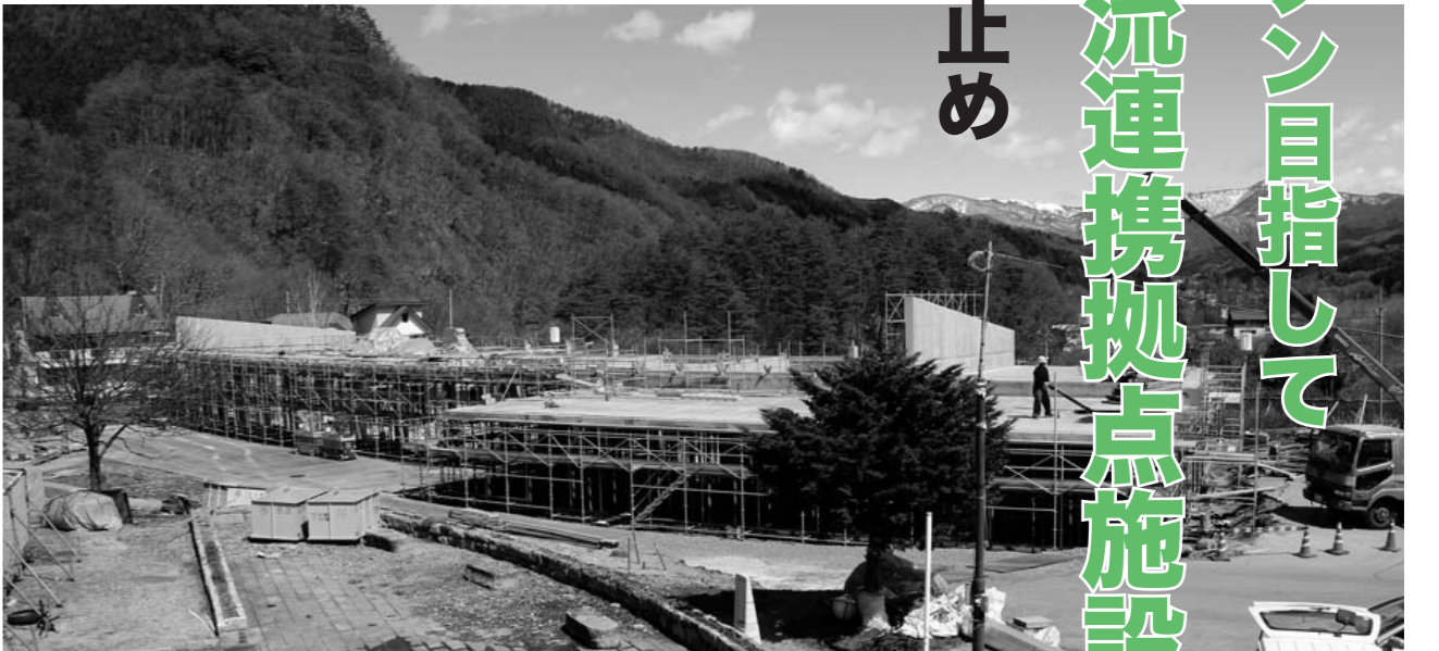
4月18日現在の工事の様子
