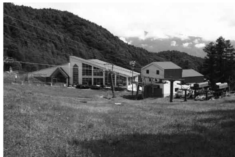
正面ゲレンデから見た事務所のあるレストハウスとメインリフト(4人乗り)
