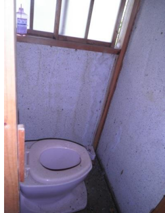
主建物1階トイレ②
