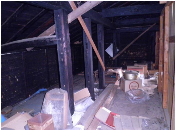
主建物2階物置
