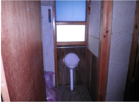
主建物1階トイレ①
