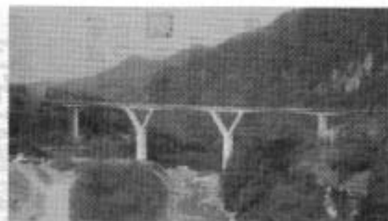
八場ダム周辺の橋梁工事
