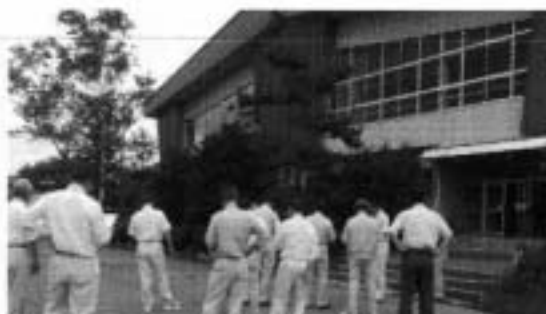
今年大規模改修される 中学校体育館
