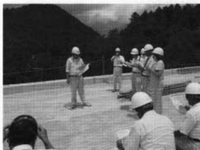
建設中の幡谷橋
