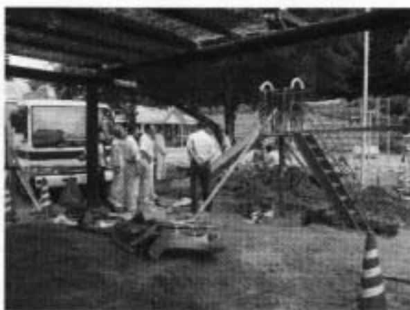
北保育園庭の遊具設置作業
