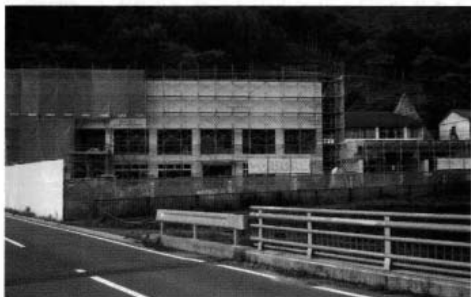
建築中の博遊館
